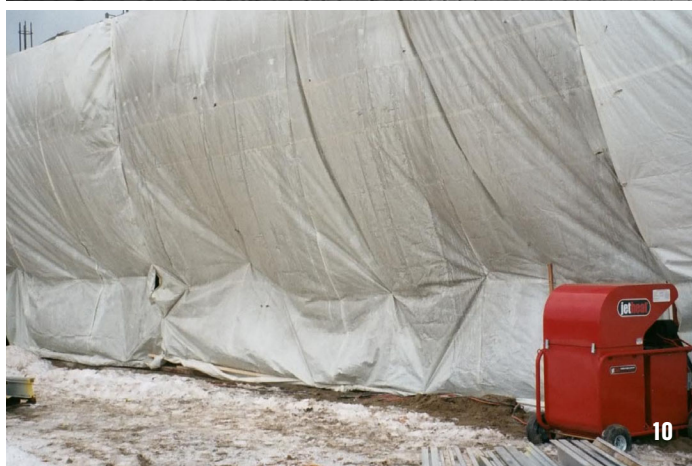
4 - Mrznutie deionizovanej vody [7]; 5 - Mrznutie roztoku \text{Ca}(\text{OH})_2 [7]; 6 - Výsledok zamrznutia betónu počas formovania väzieb [8]; 10 - Uzavretie a vykurovanie priestoru pri zimnej betonáži
