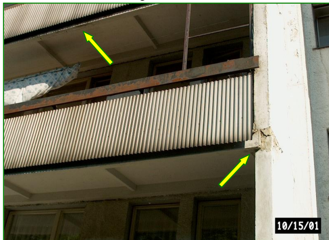
▲ Pohľad na predsadenú lodžiu – pôvodný stav View of protruding loggia - original condition
