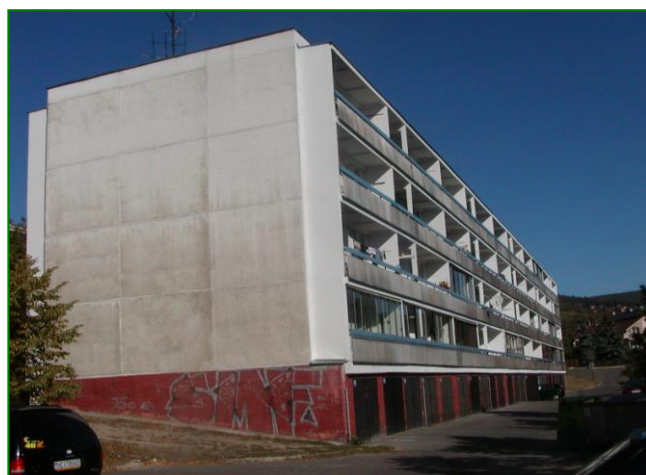
Celkový pohľad na fasádu s obnovenými lodžiami Overall view of façade with upgraded loggias
