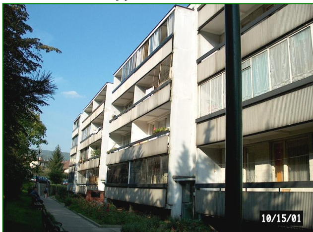
▲ Pohľad na čelnú fasádu bytového domu – pôvodný stav View of the front façade of the apartment building – original condition.
