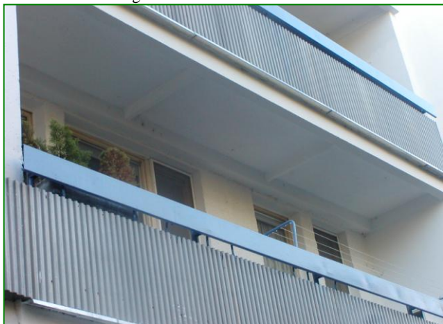
Pohľad na obnovenú lodžiu View of the upgraded loggia
