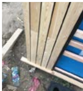
Obr. 3 - Zobrazenie roštu prevetrávanej fasády a typ mechanickej kotvy
