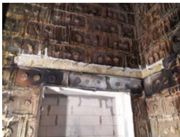
Obr. 6 - Zkušební vzorek ETICS po zkoušce a demontáži pruhu z minerální vlny z podkladu
