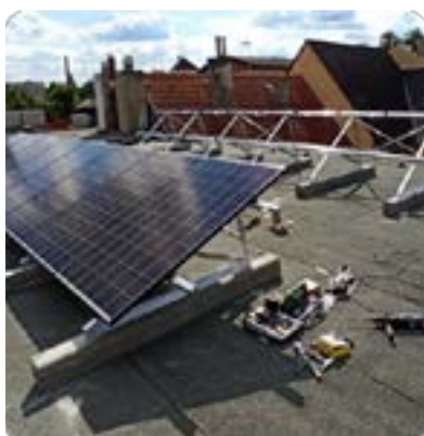
Obr. 6, 7 - Při montáži FVE hrozí prošlapání tepelné izolace a poškození povlakové hydroizolace konstrukcí, nářadím,
