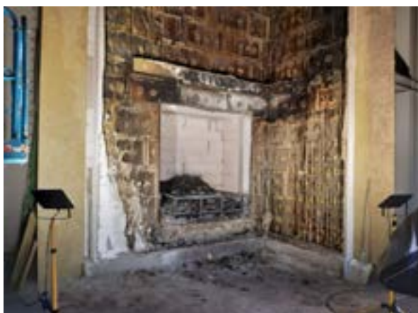
Obr. 5 - Zkušební vzorek ETICS po zkoušce a po demontáži vnějšího souvrství v oblasti pruhu z minerální vlny nad spalovací komorou
