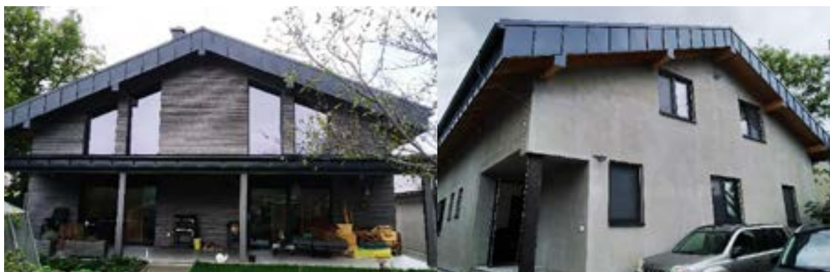
Obr.1 - Čelný pohľad na meraný rodinný dom v obci Rosina
