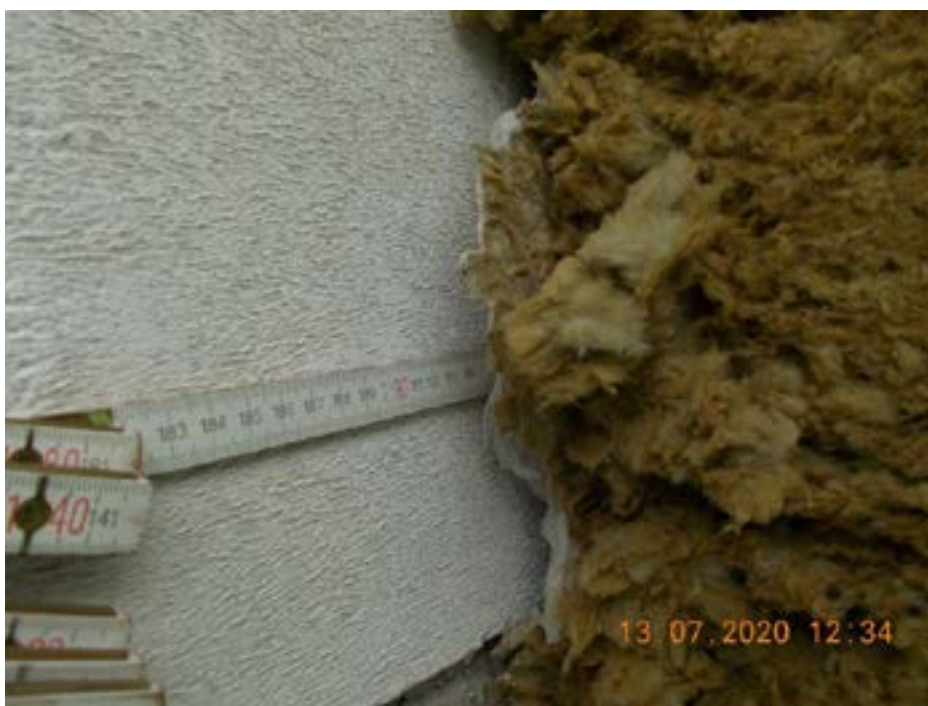
Obr. 5 - Podezření na ztrátu funkce lepeného spoje mezi izolantem a podkladem
