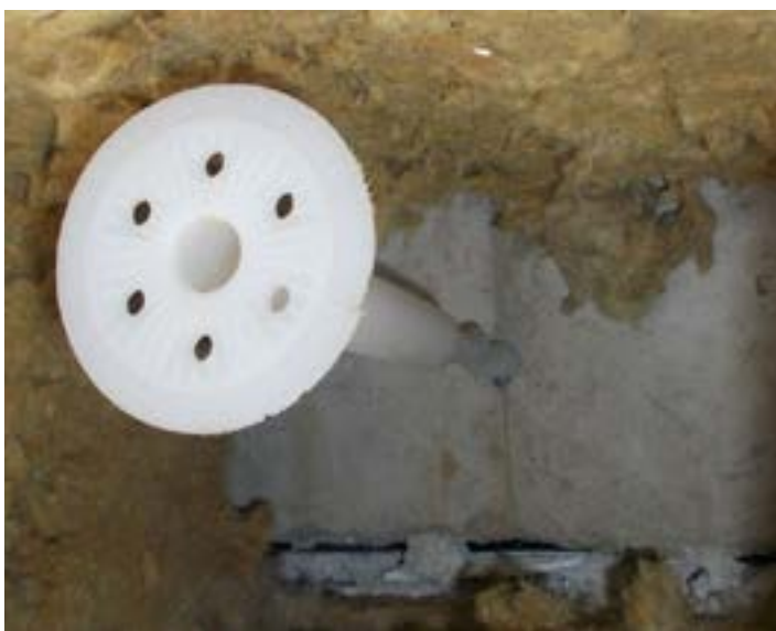
Obr. 4 - Nesprávné rozmístění hmoždinek mimo lepicí body
