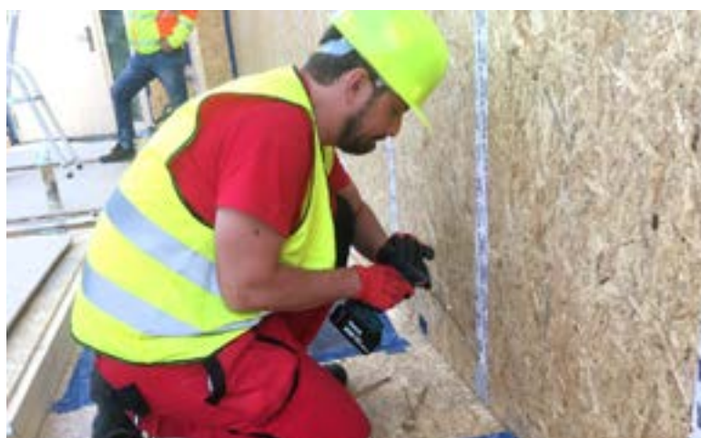
Obr. 6 - Trvalé zajištění spoje svislé a vodorovné konstrukce šikmými vruty. Spoje jsou přelepeny páskami.
