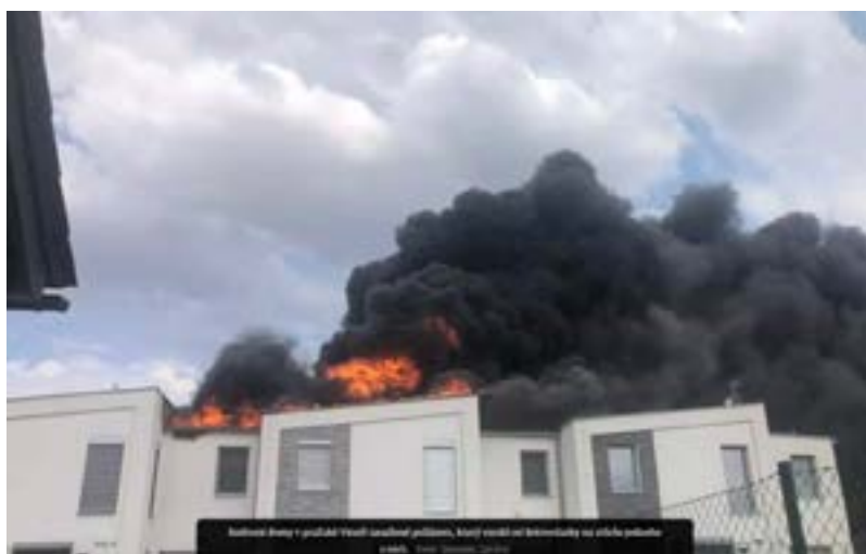
Obr. 3 - Skutečný požár vzniklý od FVE – Praha Vinoř 2022. Hlavní nebezpečí tvoří riziko zapálení střešní konstrukce
