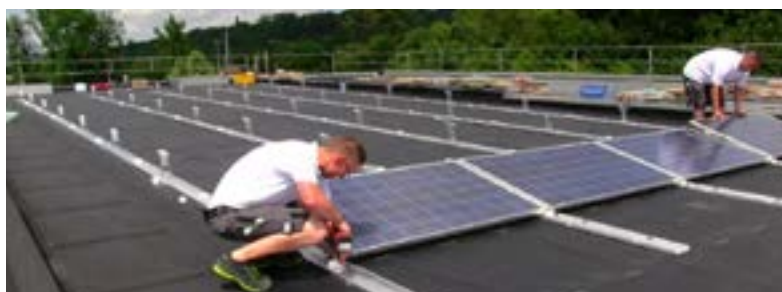
Obr. 6, 7 - Při montáži FVE hrozí prošlapání tepelné izolace a poškození povlakové hydroizolace konstrukcí, nářadím,
