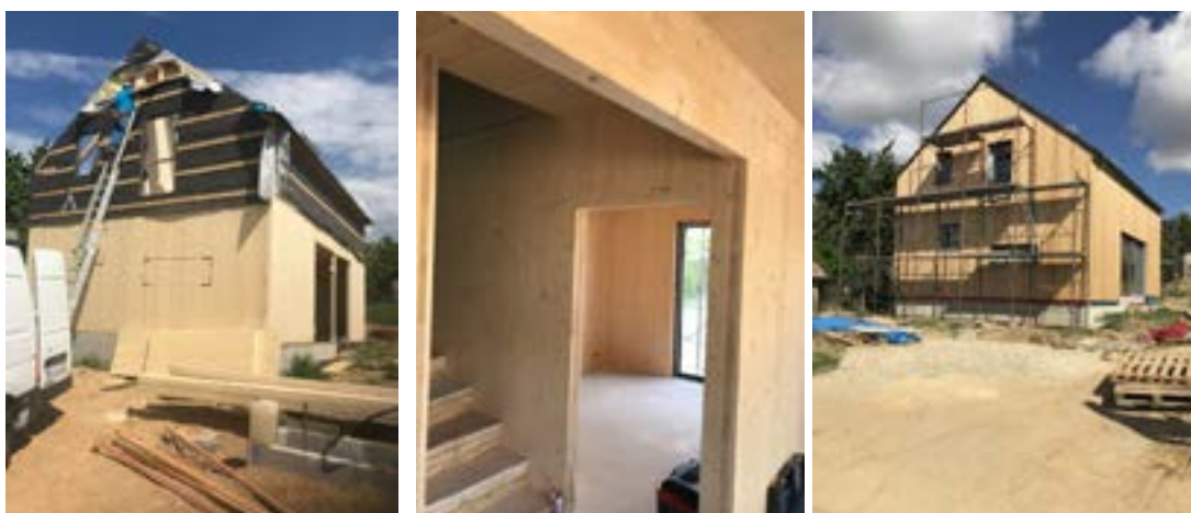
Obr. 2 - Zobrazenie nosnej konštrukcie a prevetrávanej fasády
